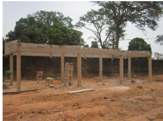
Het betonnen skelet van de kleinveestal staat
