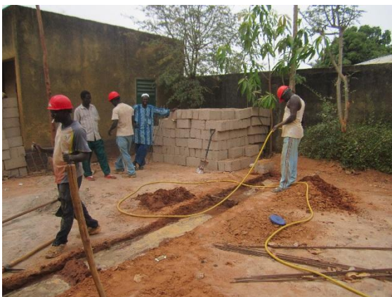
Stenen worden van cement en zand ter plaatse gemaakt
