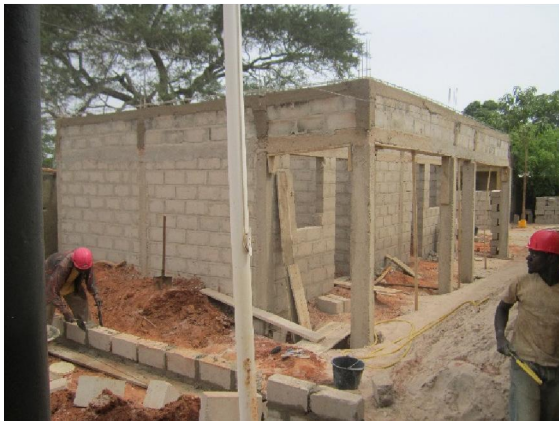
Bouw van de twee hotelkamers vordert goed
