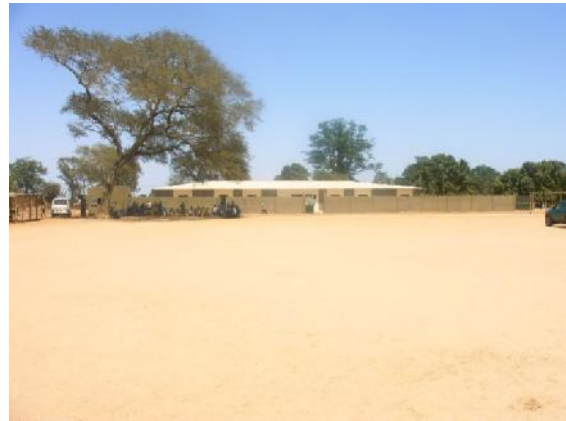
Gebouw en muur CFP: 2007
